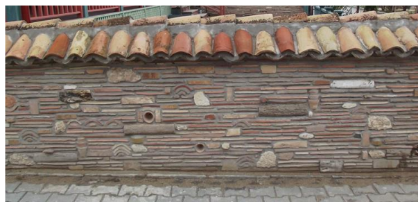
AȘA DA: Gard din olane sau țigle sparte refolosite. (Vama Veche)
