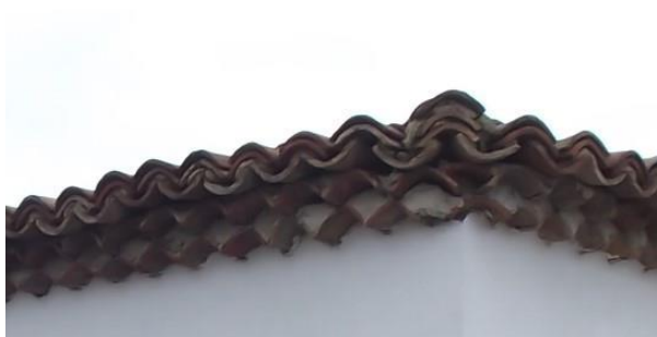
AȘA DA: Streașină cu olane cu marcarea cornișei prin dispunerea de straturi de olane suprapuse. (Limanu)
