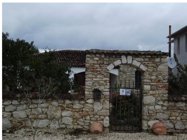
AȘA DA: Poartă în zid de piatră cu marcarea arcului fals. (Limanu)
